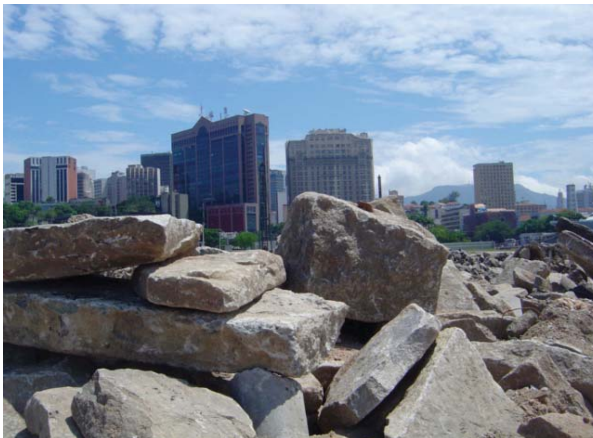
Figura 1 - Obras no Pier Mauá
