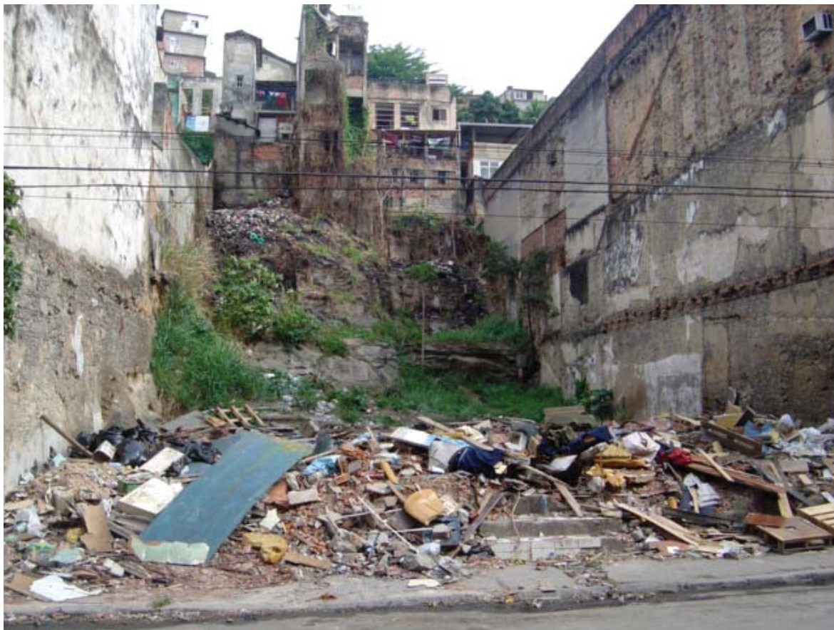
Figura 3 - Imóvel demolido pela SMH na Rua do Livramento.
