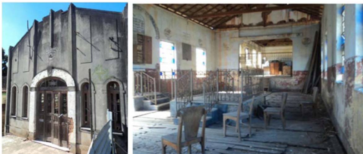
Figura 2: Fachada e interior da Sinagoga Tiferet Israel
