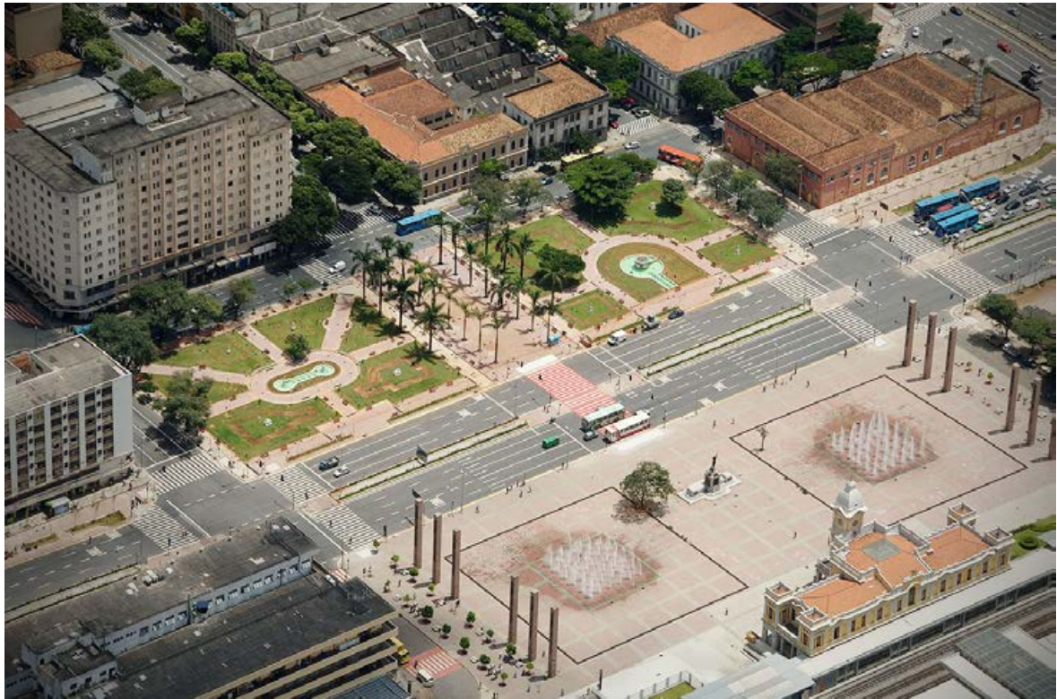
Figura 1: Conjunto da Praça Rui Barbosa
